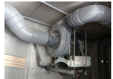
Ventilateur centrifuge
