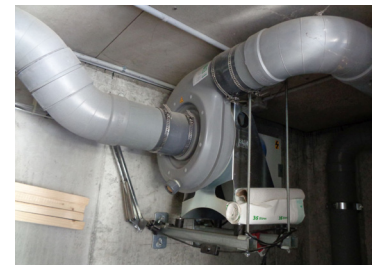
Ventilateur centrifuge
