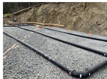
F.3 Drainage radon en PE
