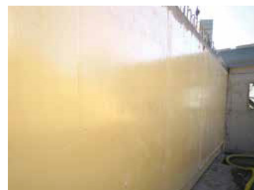
F.3 Membrane pare-radon
