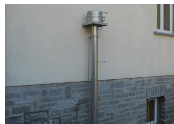
F.8 Extension de la canalisation pour expulser l'air contaminé
