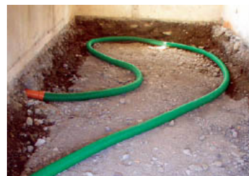
F.5 Exemple de drainage en S
