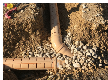
F.4 Drainage radon et eau en PP
