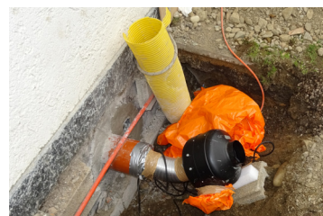
F.5 Installation pilote d'un puits à radon extérieur
