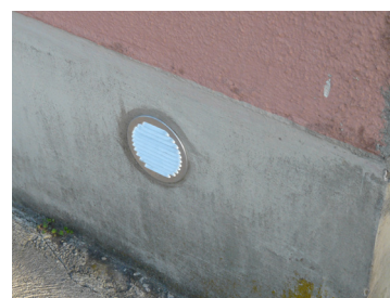
F.4 Ouverture dans le vide sanitaire
