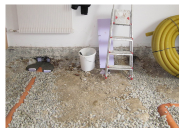
F.7 Pose du drainage dans un lit de gravier
