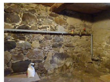
F.7 Murs en moellons
