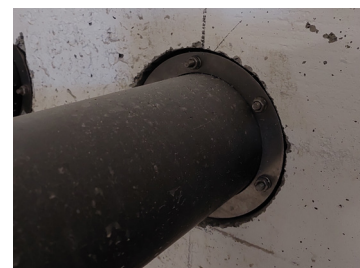
F.6 Fourreau étanche pour traversée de paroi
