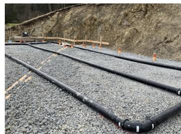
F.3 Drainage radon en PE
