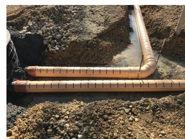
F.7 Coude dans un drainage mixte radon/eau en PP
