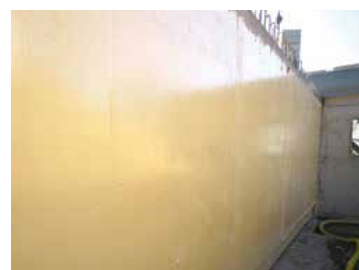
F.3 Membrane pare-radon
