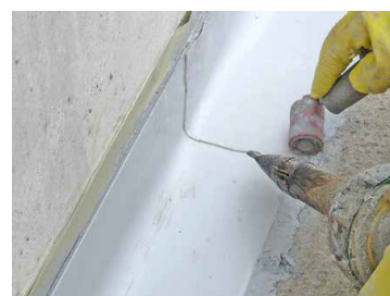
F.2 Joint de reprise de bétonnage
