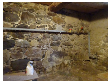
F.7 Murs en moellons
