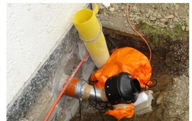
F.5 Installation pilote d'un puits à radon extérieur
