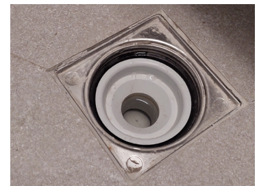
F.7 Bodenablauf mit Siphon
