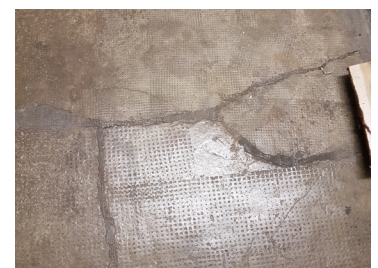
F.4 Abdichten von Rissen
