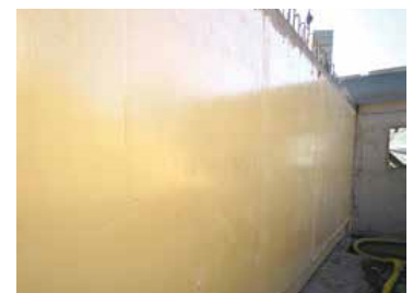
F.3 Radonsperrschicht
