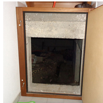
F.4 Luftdichte Klappe zum Kriechkeller
