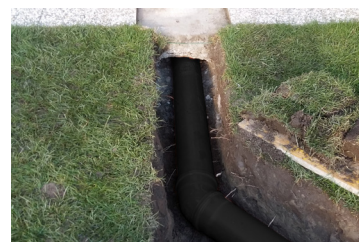
F.6 Verlängerung der Rohrleitung im Boden für eine weiter vom Gebäude entfernte Luftabführung
