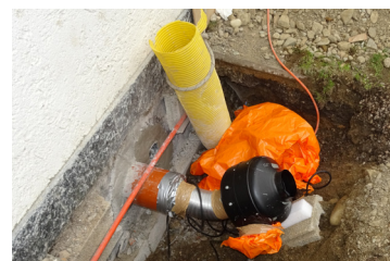
F.5 Provisorische Installation eines externen Radonbrunnens
