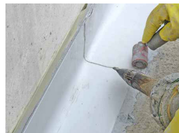
F.2 Giunto di ripresa del betonaggio
