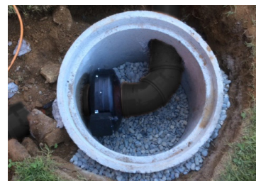
F.7 Tombino per la manutenzione del ventilatore
