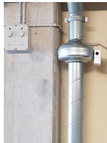
F.6 Sistema attivo, condotta e ventilatore esterni
