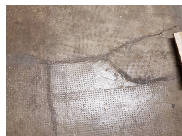
F.4 Riempimento di fessurazioni
