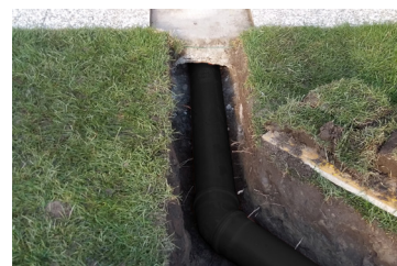
F.6 Prolungamento della condotta nel terreno per allontanare il punto di espulsione
