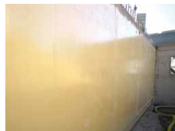
F.3 Vasca gialla come membrana anti-radon
