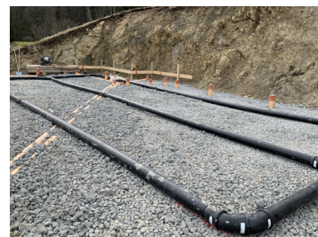
F.3 Drenaggio radon in PE
