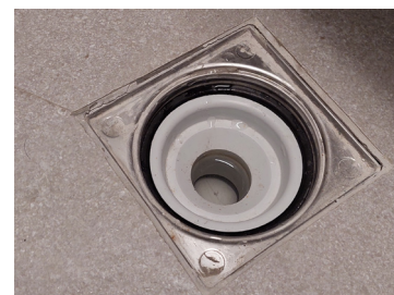
F.7 Griglia a pavimento con sifone
