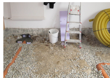
F.7 Drenaggio annegato nello strato di ghiaia
