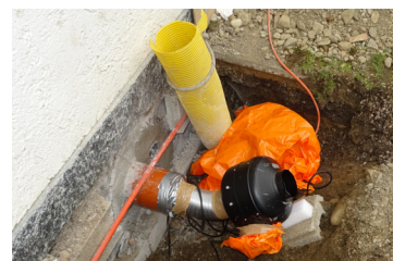
F.5 Impianto pilota di un pozzo radon esterno
