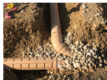
F.4 Drenaggio radon/acqua in PP
