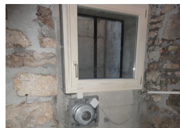
F.4 Ventilatore inserito nella parete e uscita nel pozzo luce
