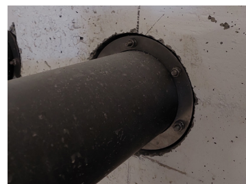
F.6 Manicotto ermetico per l'attraversamento di una parete
