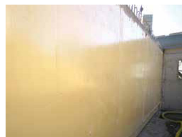
F.4 Vasca gialla come membrana anti-radon
