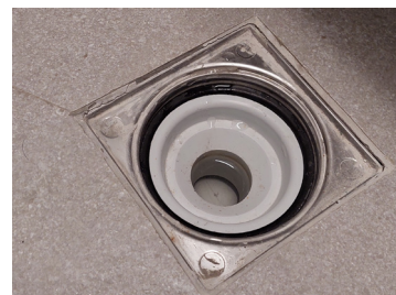
F.7 Griglia a pavimento con sifone
