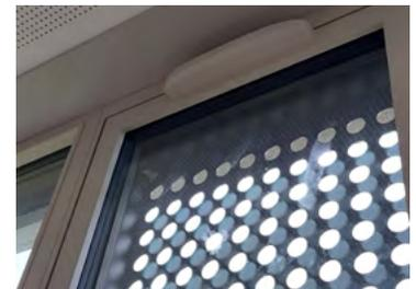
Griglia di ventilazione su telaio della finestra
