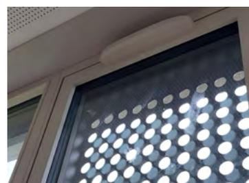
Griglia di ventilazione sul telaio della finestra
