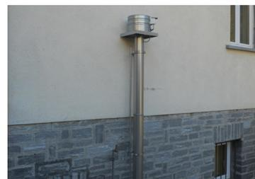
F.8 Prolungamento della condotta per l'espulsione dell'aria contaminata
