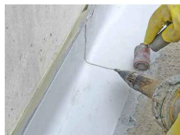
F.3 Giunto di ripresa del betonaggio
