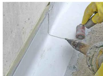
F.2 Giunto di ripresa del betonaggio
