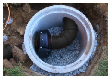
F.7 Tombino per la manutenzione del ventilatore
