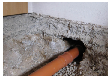
F.6 Uscita della condotta di drenaggio
